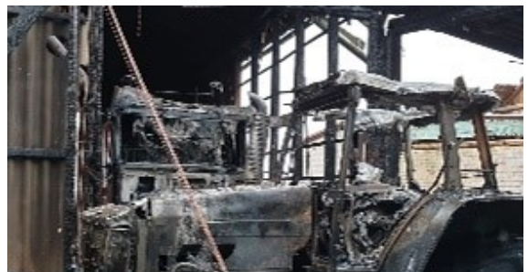
Maschinenhallenbrand in Bockholt im Februar 2019 Foto: FFw Rosche, Frank Nieschulze
